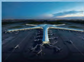
25 Flughafen-Jiaodong (im Bau)
