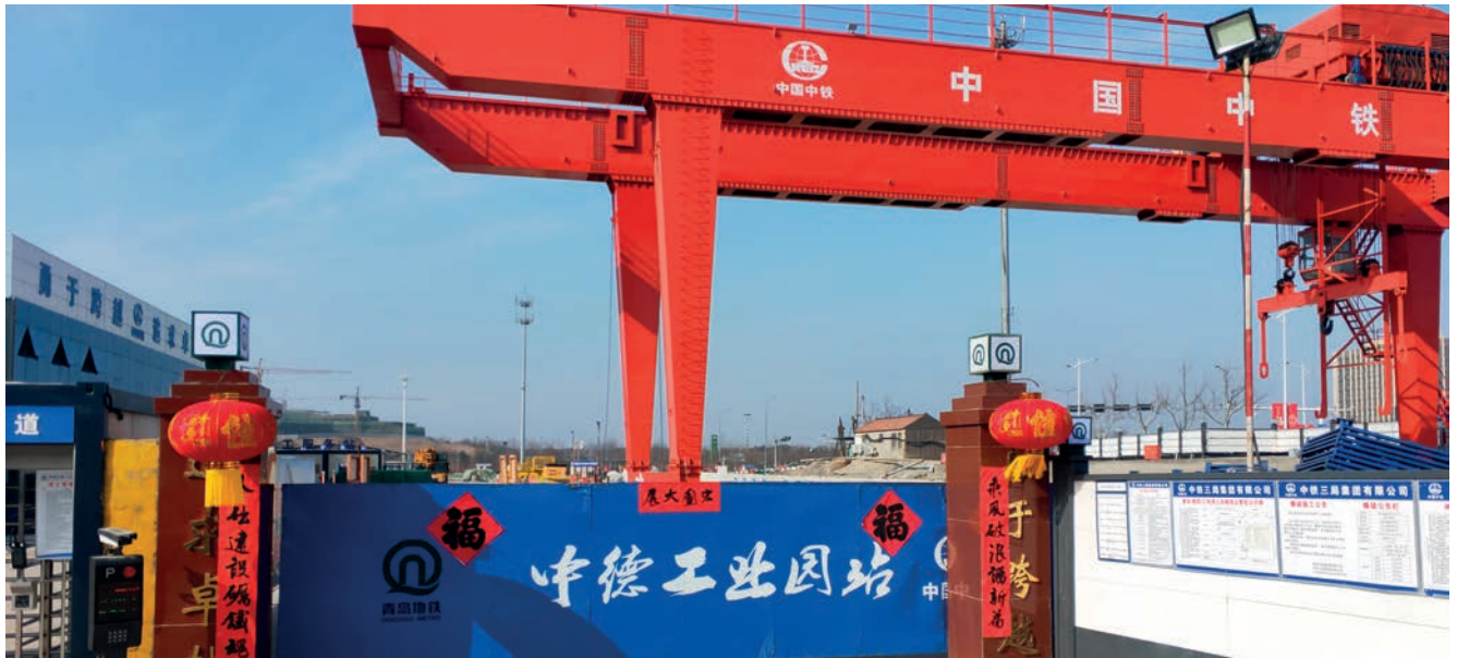
U-Bahn-Baustelle im Ökopark: Vier Stationen wird es ab Ende 2023 im Gewerbegebiet geben.
